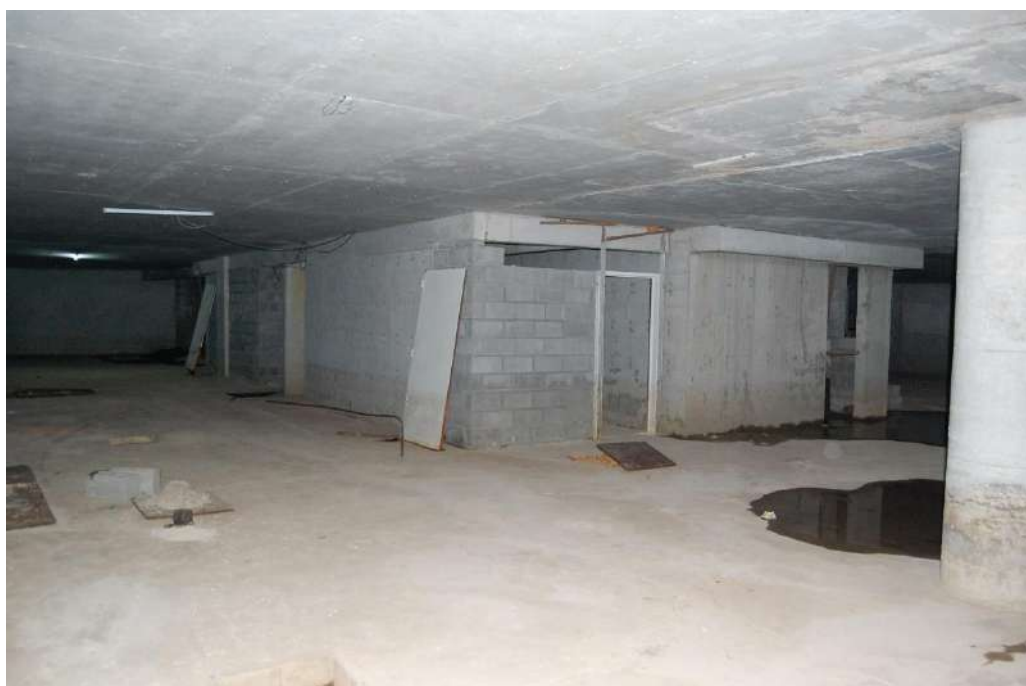
ESTADO DE LA OBRA EN 2° SS
