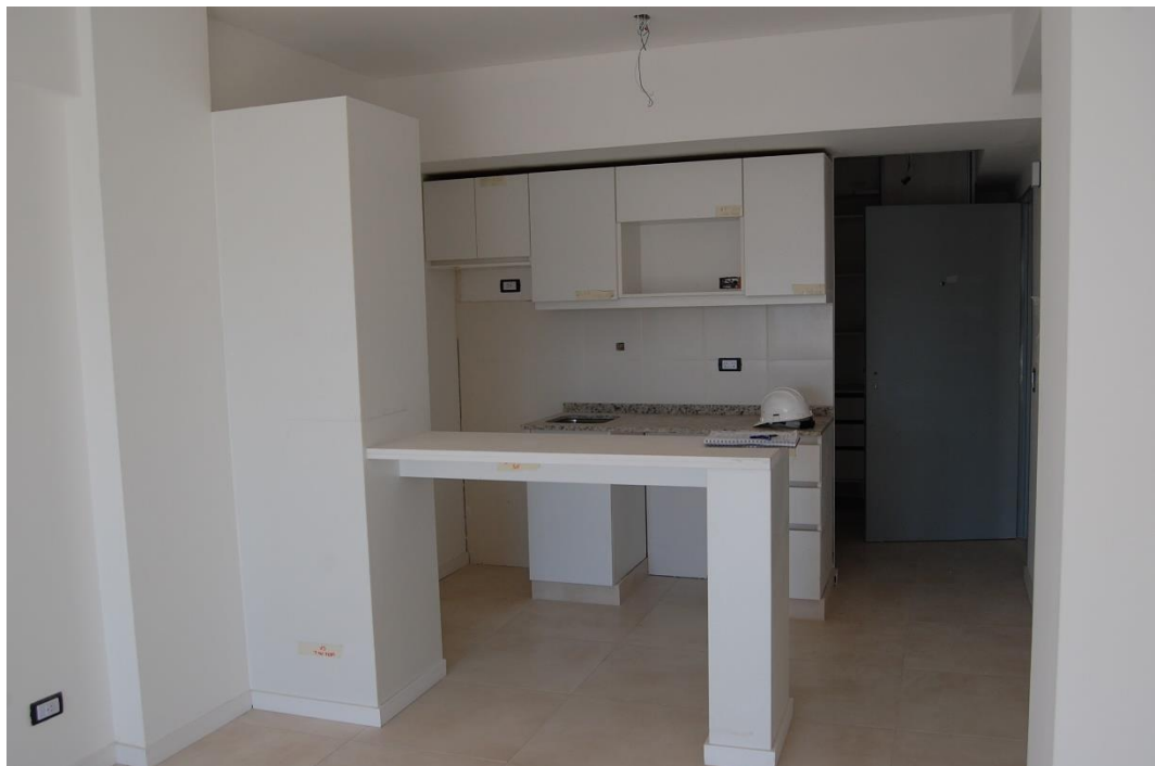
FOTO #4 – UNIDAD FUNCIONAL 5F
