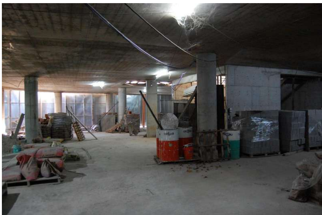
ACOPIO DE MATERIALES EN PB
