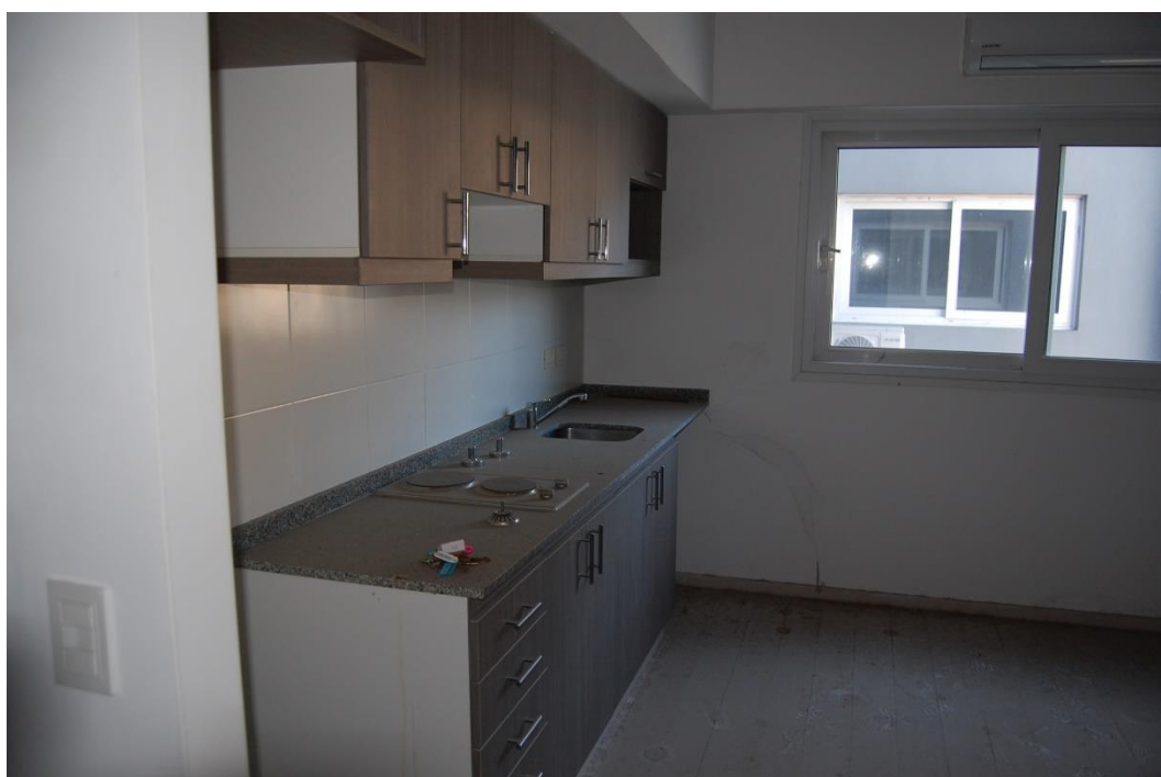
FOTO #24 – UNIDAD FUNCIONAL 10E
