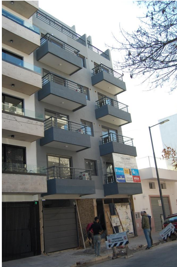
FOTO #1 – FACHADA DEL EDIFICIO
