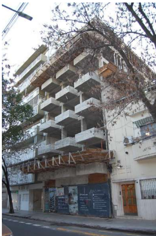
VISTA DEL FRENTE DE LA OBRA DESDE ACUÑA DE FIGUEROA
