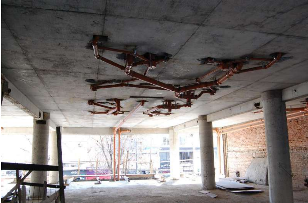
PISO 1° - ARAÑAS DE DESAGÜE CLOACAL COMPLETADAS
