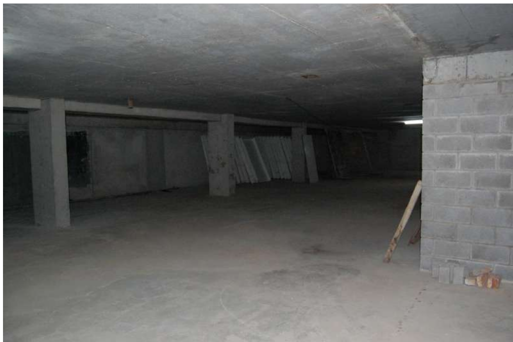
ESTADO DE LA OBRA EN 1° SS
