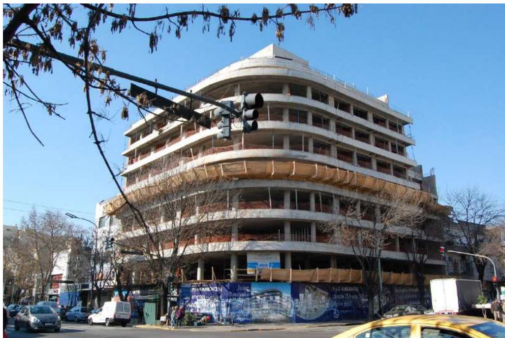
VISTA DE LA OBRA DESDE LA CALLE
