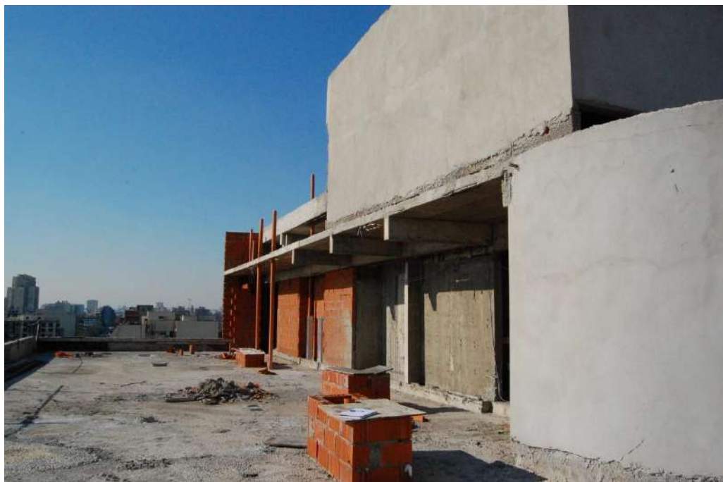
PISO 9° - ALBAÑILERÍA Y REVOQUE EXTERIOR EN SALAS DE MÁQUINAS
