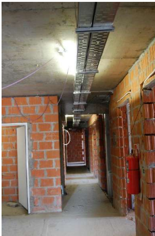
PISO 2° - TENDIDO DE BANDEJA ELÉCTRICA EN PASILLO
