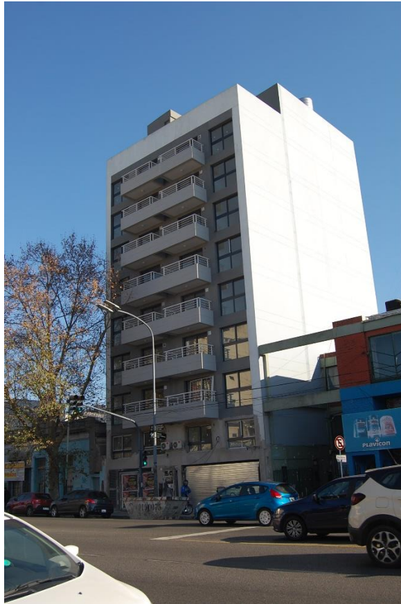
FOTO #1 – FACHADA DEL EDIFICIO
