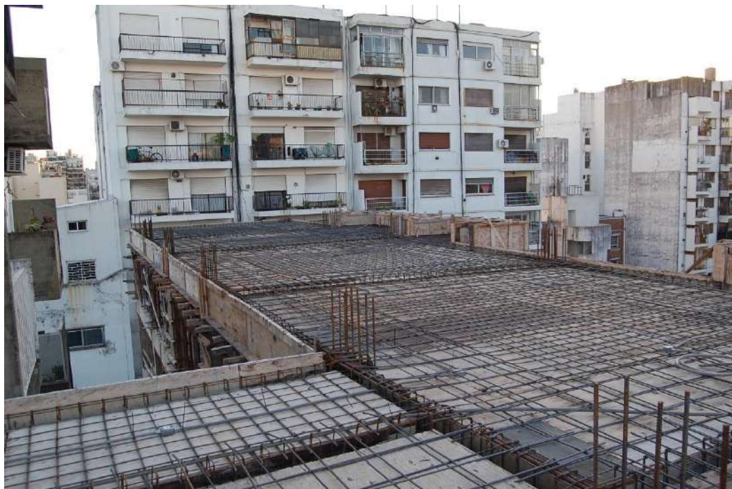
LOSA S/6° ENCOFRADA Y ARMADA, SECTOR FONDO
