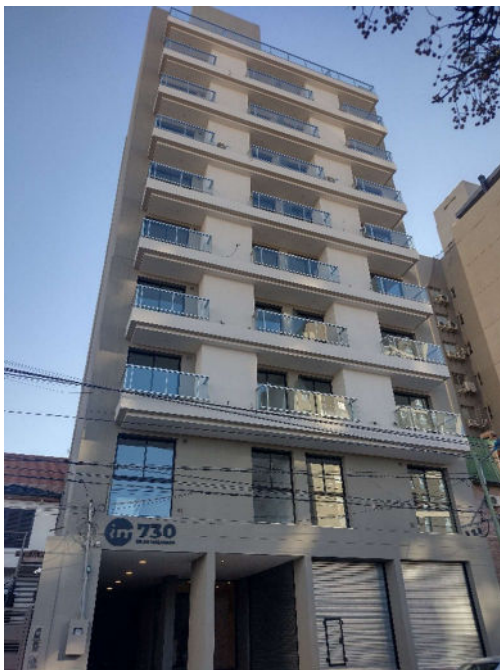
Frente actual Calle I. Malvinas
