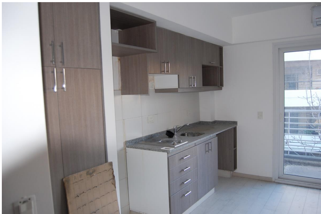
FOTO #1 – UNIDAD FUNCIONAL 3A
