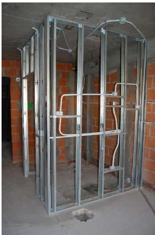
PISO 2° – ESTRUCTURA DE DURLOCK CON TENDIDOS ELÉCTRICOS
