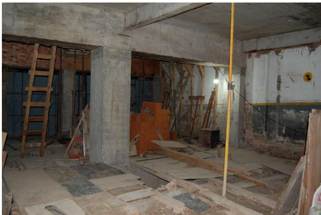
VISTA INTERIOR DE PB HACIA FRENTE
