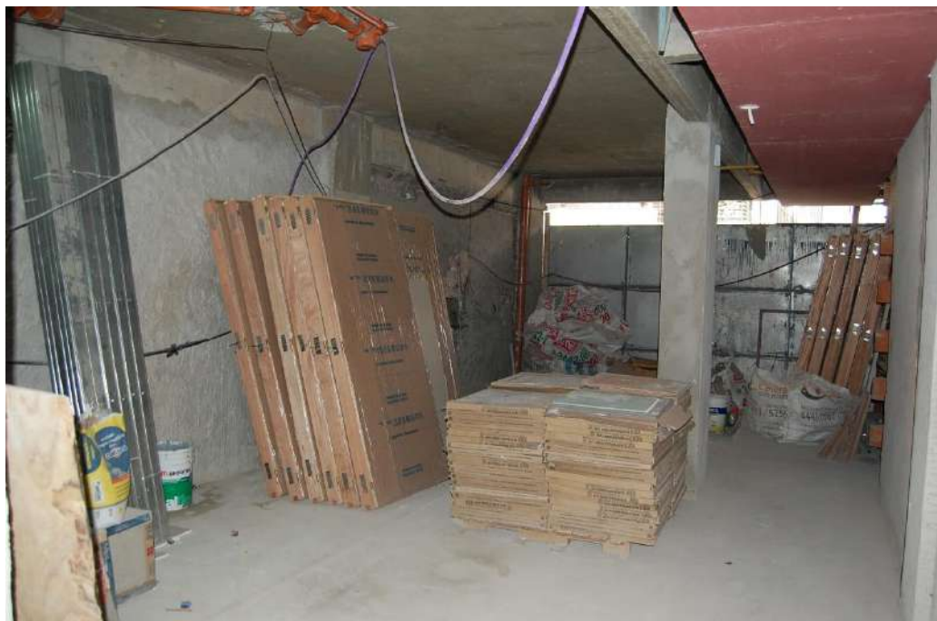
VISTA GENERAL DE ACOPIOS EN PB
