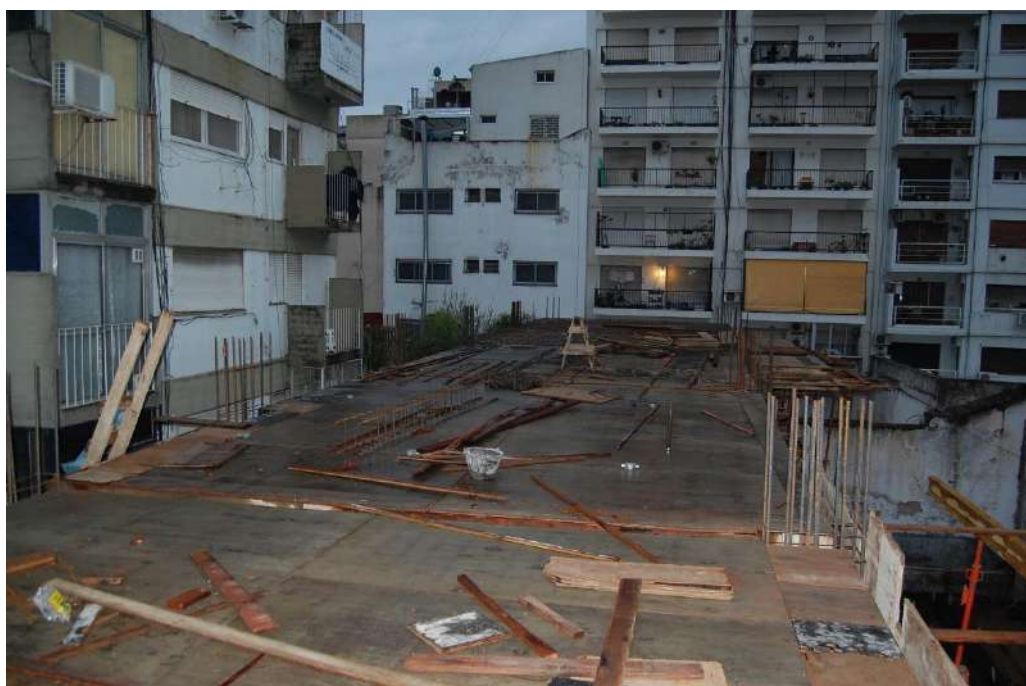
SECTOR FONDO – LOSA s/2 PISO ENCOFRADA Y PARCIALMENTE ARMADA
