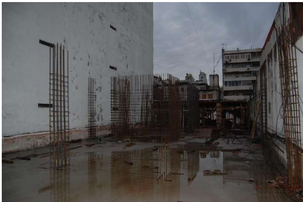
SECTOR FRENTE - LOSA s/1º PISO HORMIGONADA
