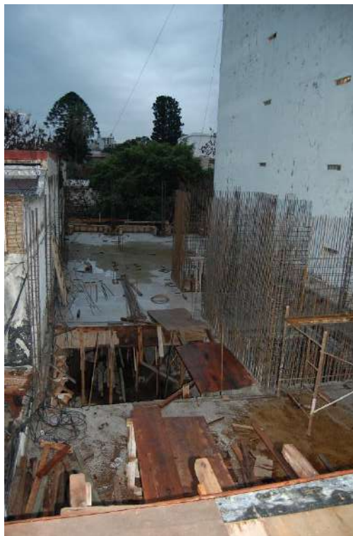
VISTA DE LA LOSA S/1º PISO HACIA FRENTE
