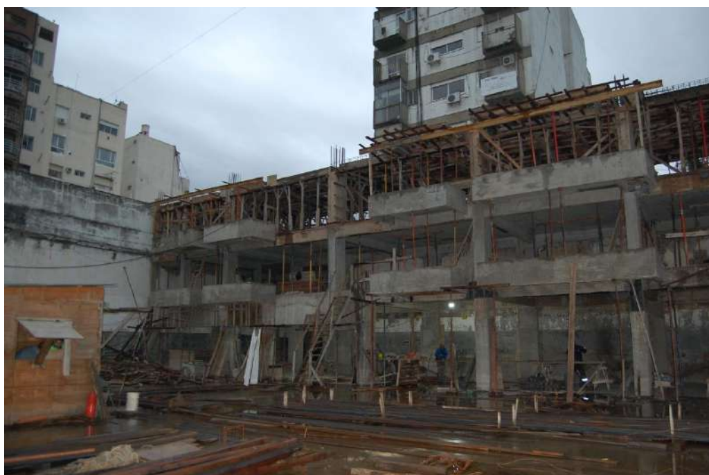
SECTOR FONDO – LOSAS s/PB Y s/1ºP EJECUTADAS Y LOSA s/2ºP ENCOFRADA CON ARMADURA PARCIAL
