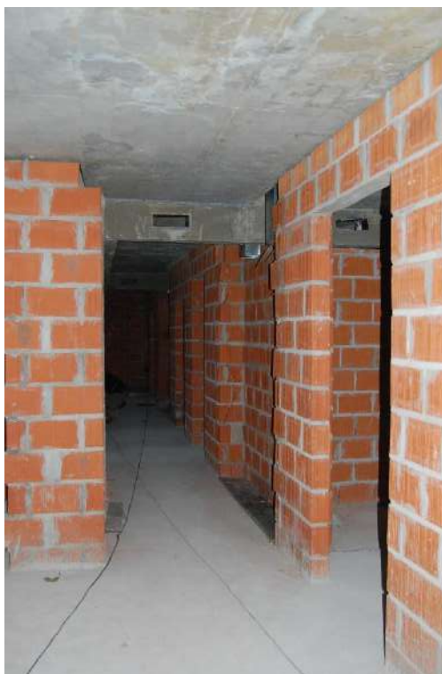
3°P – MAMPOSTERÍAS, CONTRAPISOS Y CARPETAS EJECUTADAS
