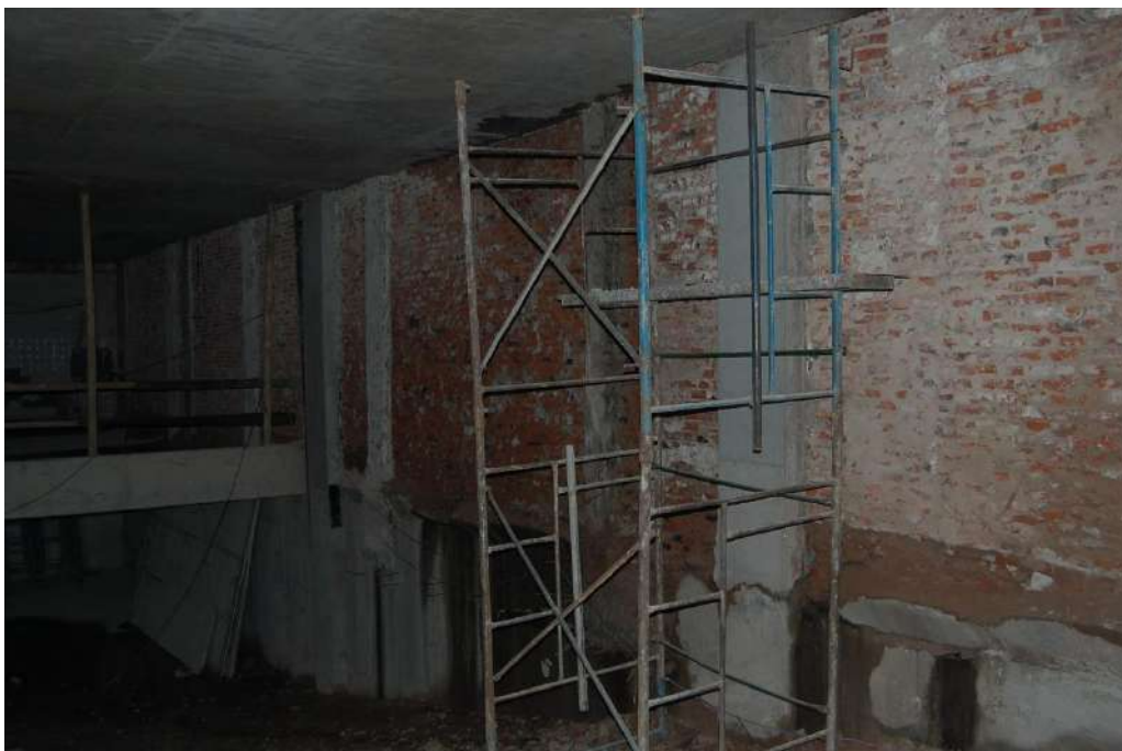
PICADO DE REVOQUES EN MEDIANERA 1° SS LADO LARRAZÁBAL
