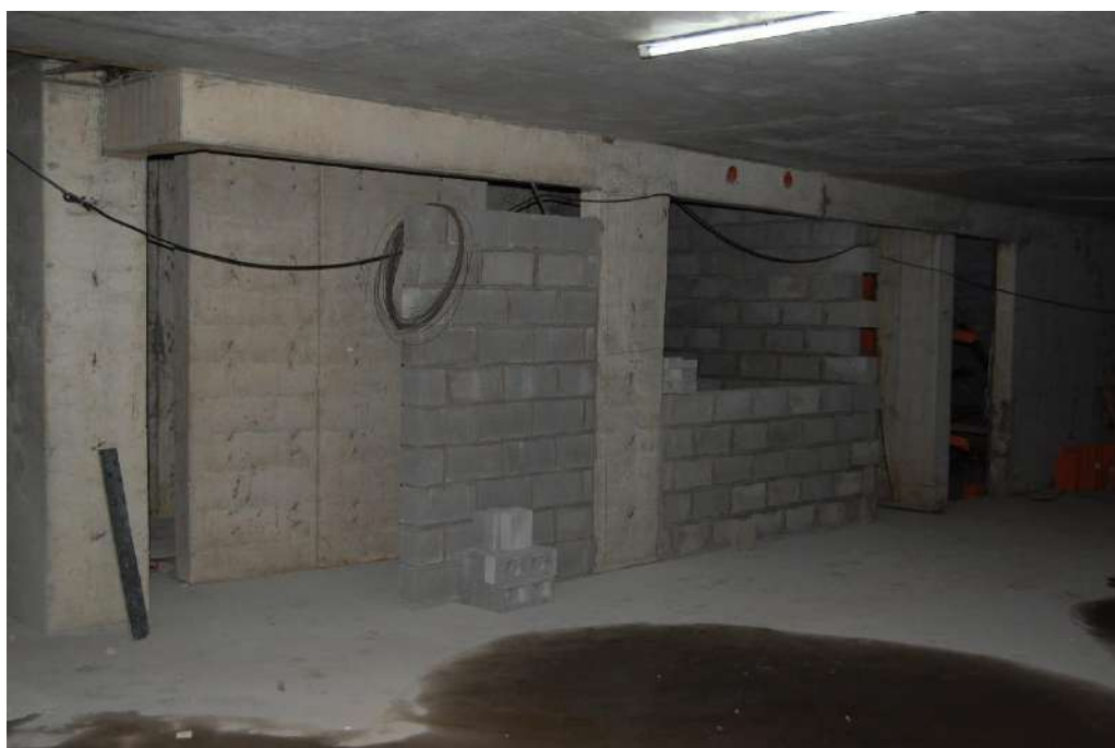
MAMPOSTERÍA DE BLOQUES DE HORMIGÓN EN NÚCLEO 1ºSS
