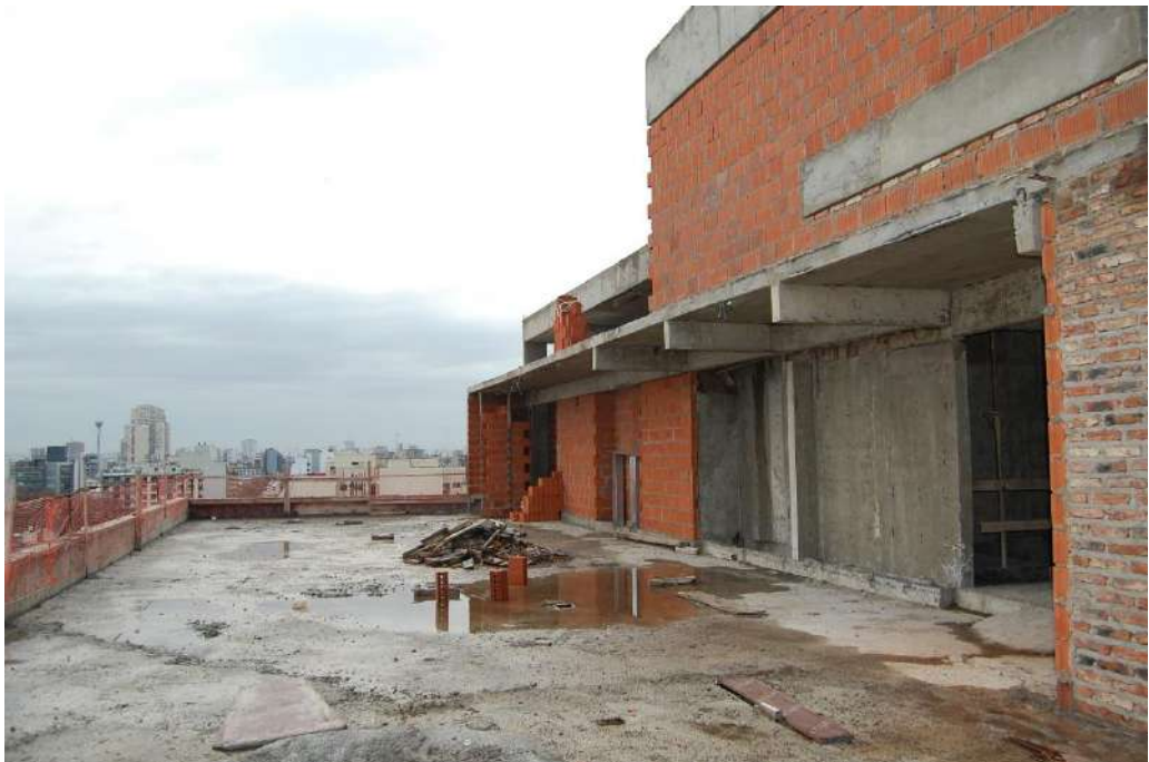
PISO 9° - MAMPOSTERÍAS EXTERIORES
