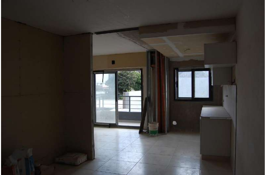
VISTA ESTADO EJECUCIÓN UNIDAD PISO 1°
