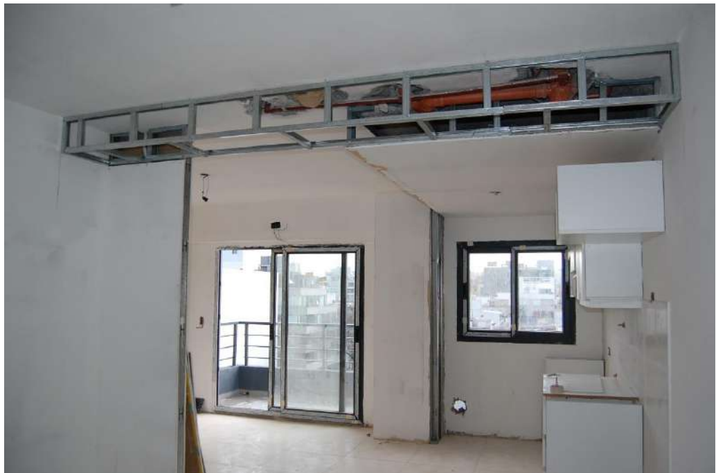
VISTA ESTADO EJECUCIÓN UNIDAD PISO 6º
