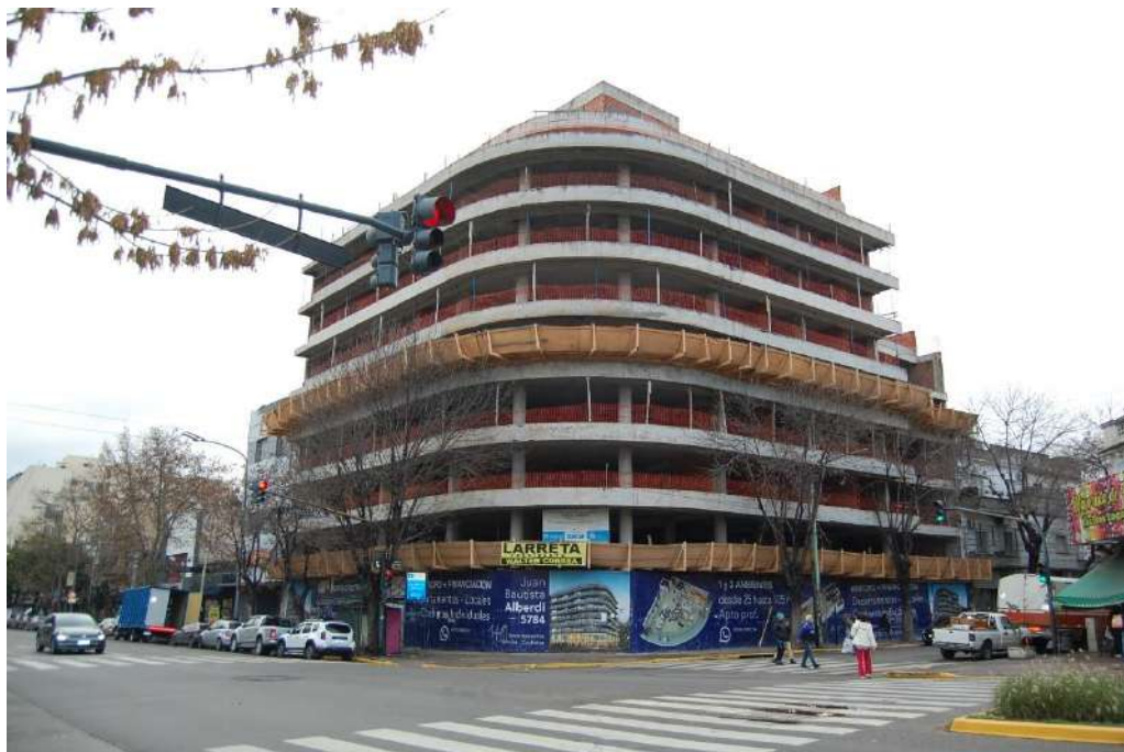
VISTA DE LA OBRA DESDE LA CALLE
