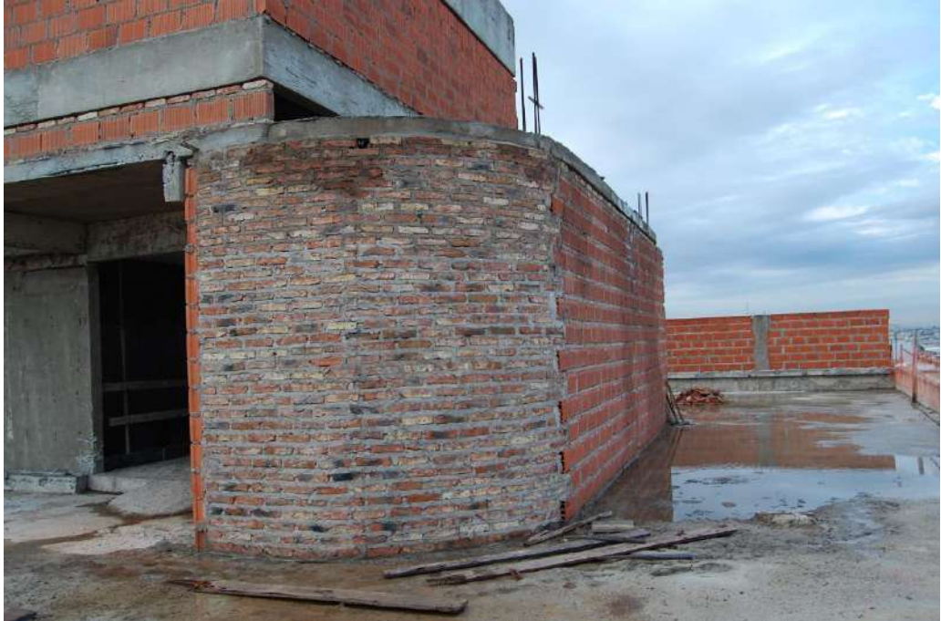
PISO 9° - MAMPOSTERÍAS EXTERIORES
