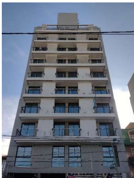
Frente actual s/Calle I. Malvinas
