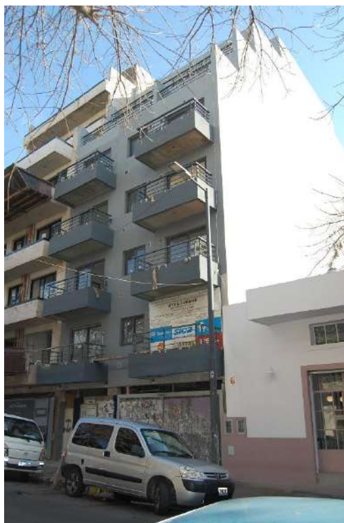
VISTA DEL FRENTE DE LA OBRA
