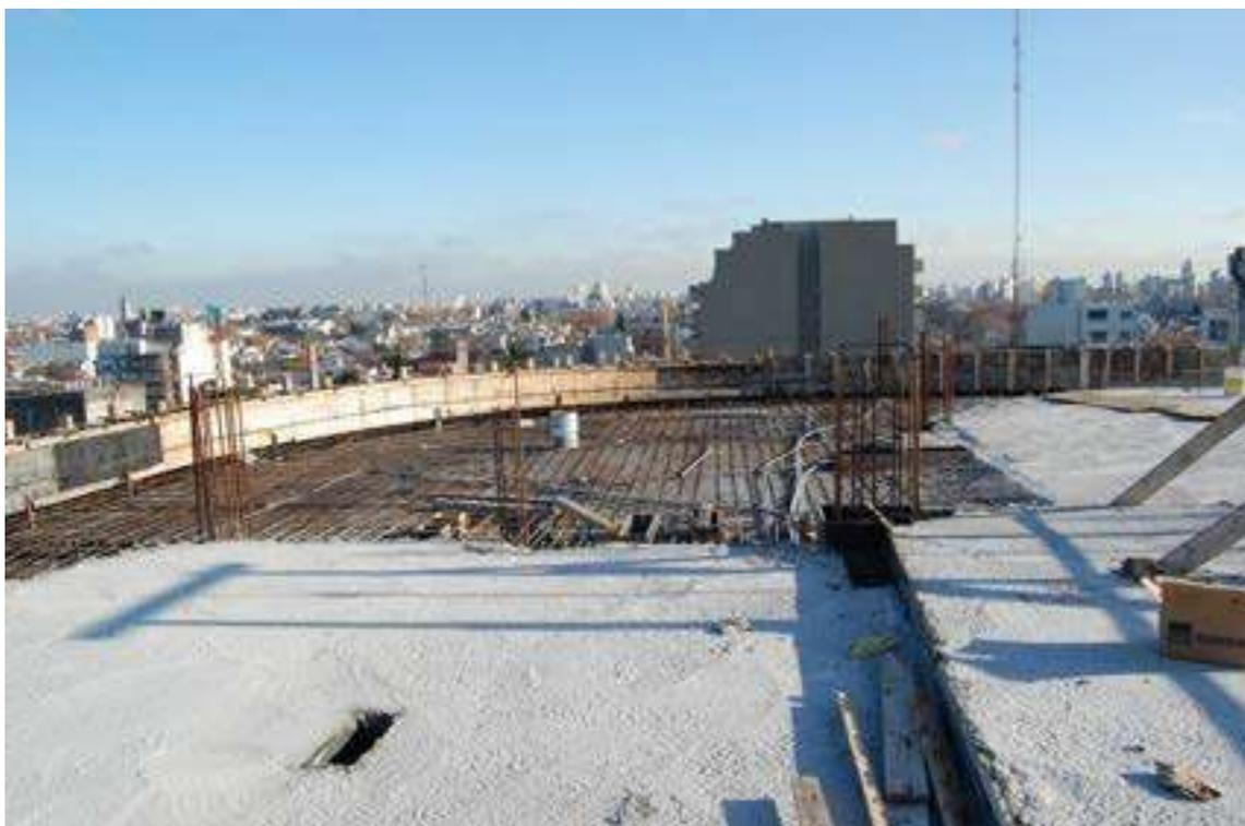
VISTA DEL SECTOR SIN HORMIGONAR DE LOSA s/8° (esquina)
