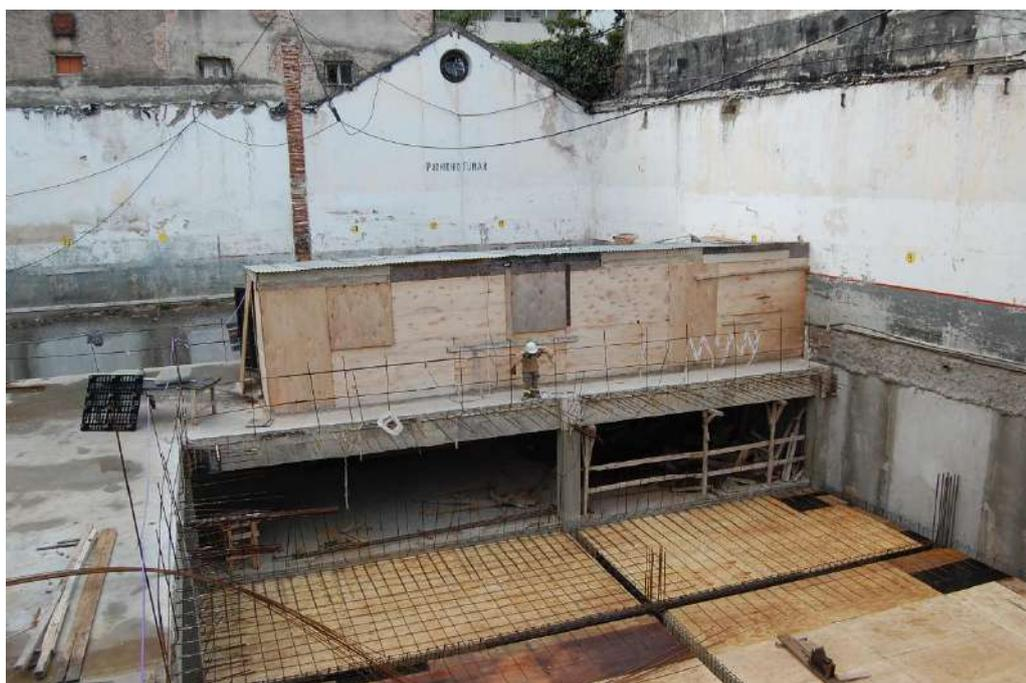
OBRADOR Y LOSA EN PROCESO DE ARMADO
