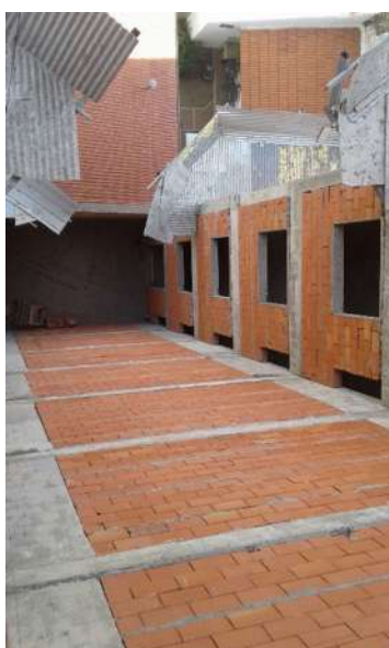
Mampostería Patios Auxiliares
