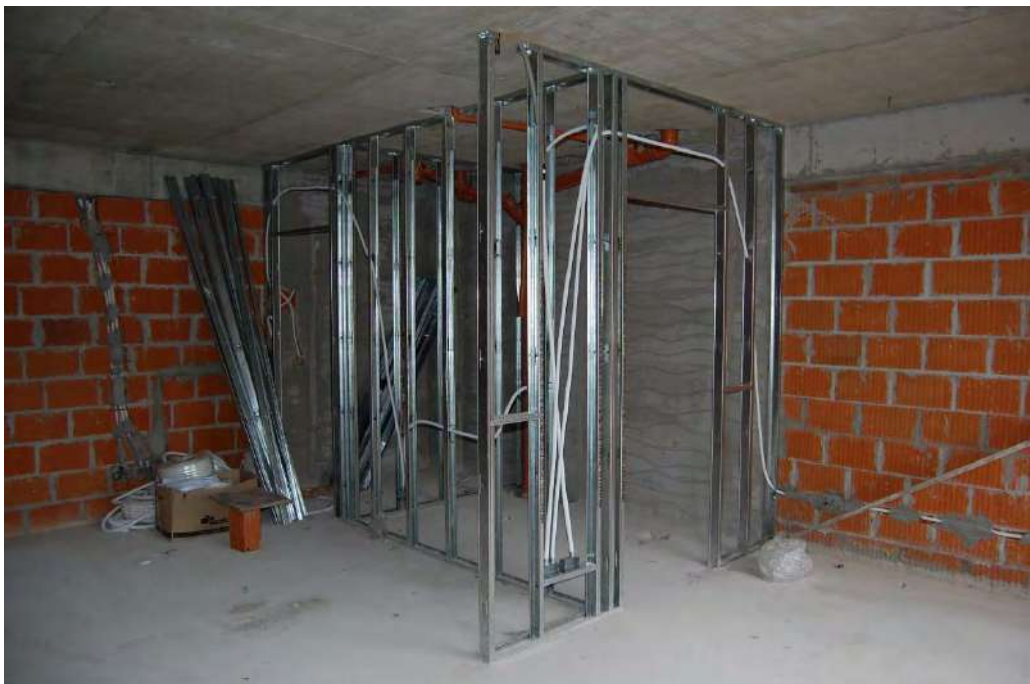
VISTA ESTADO EJECUCIÓN UNIDAD PISO 1°
