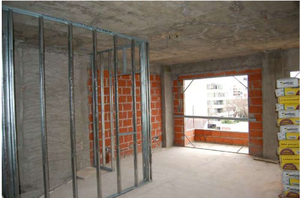
VISTA ESTADO EJECUCIÓN UNIDAD PISO 5°
