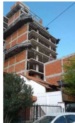
Bloque del Sector I, con frente a calle Alberti. 7 losas y Mamposterías con linderos
