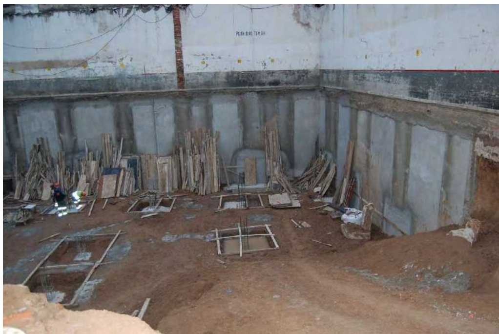
EJECUCIÓN SUBMURACIÓN EN FONDO TERRENO
