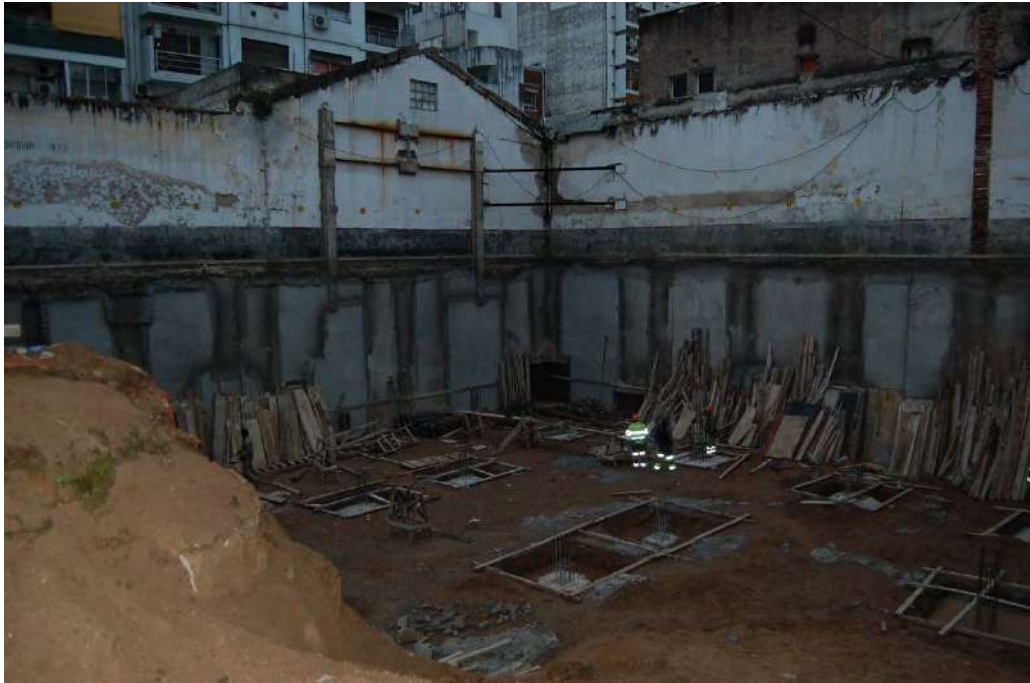
EJECUCIÓN SUBMURACIÓN EN FONDO TERRENO
