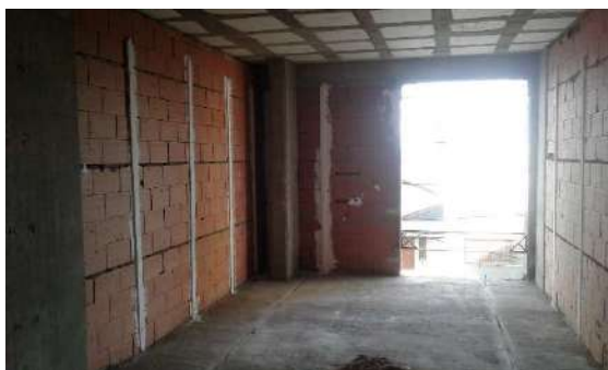
Contrapisos y carpetas. Precarpetas 1° a 5° Piso.
