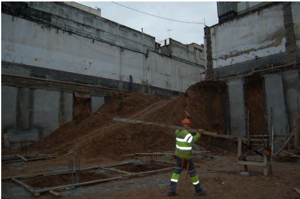
VISTA DE LA RAMPA DESDE PISO DE LA EXCAVACIÓN
