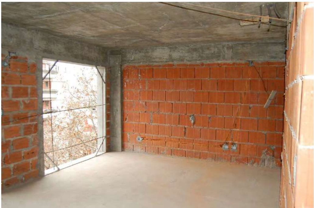
VISTA DE ESTADO UNIDAD PISO 6°
