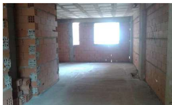
Contrapisos y carpetas. Precarpetas 1° a 5° Piso.
