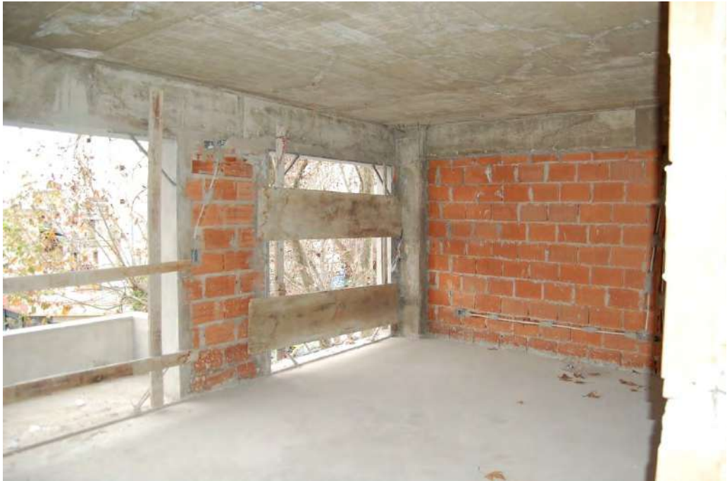
VISTA DE ESTADO UNIDAD PISO 2°
