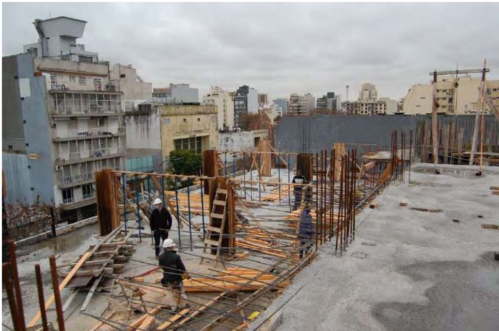
VISTA DE SECTOR DE PREPARACIÓN DESDE LOSA HORMIGONADA
