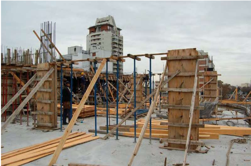
VISTA DE PREPARACIÓN DE LOSA S/4° PISO EN ANGULO SE
