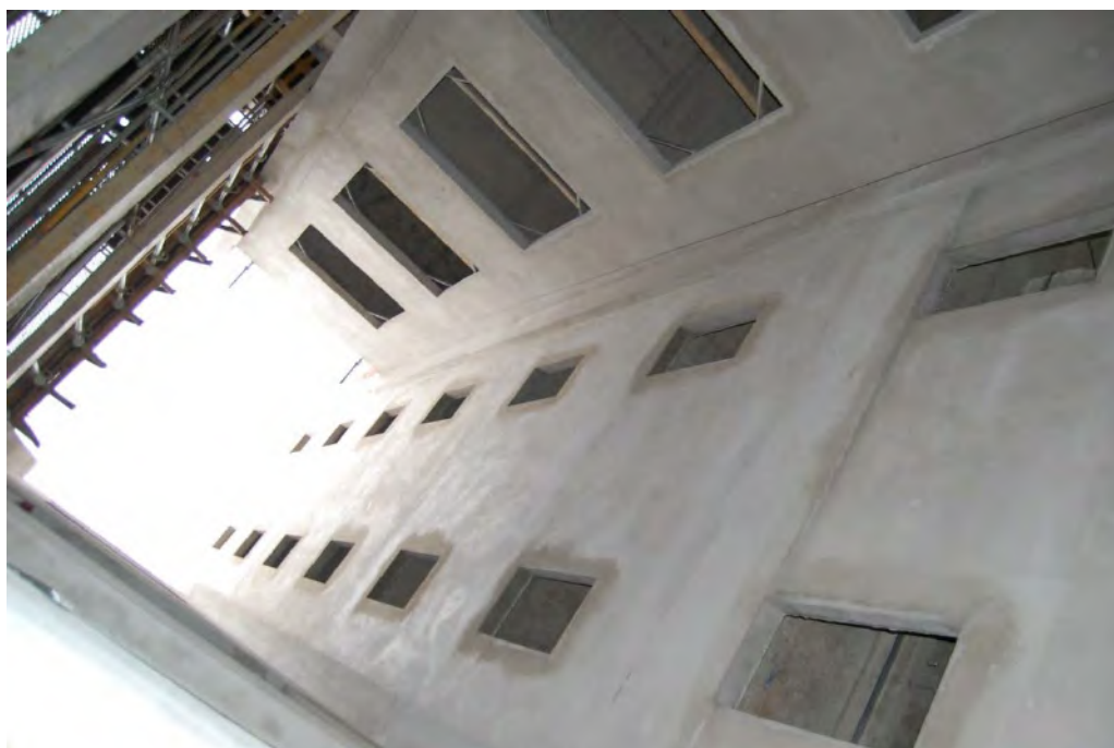
VISTA DEL PATIO INTERIOR REVOCADO
