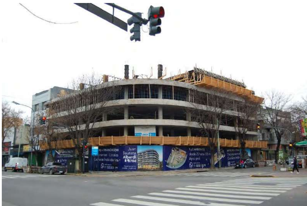
VISTA DE LA OBRA DESDE LA CALLE
