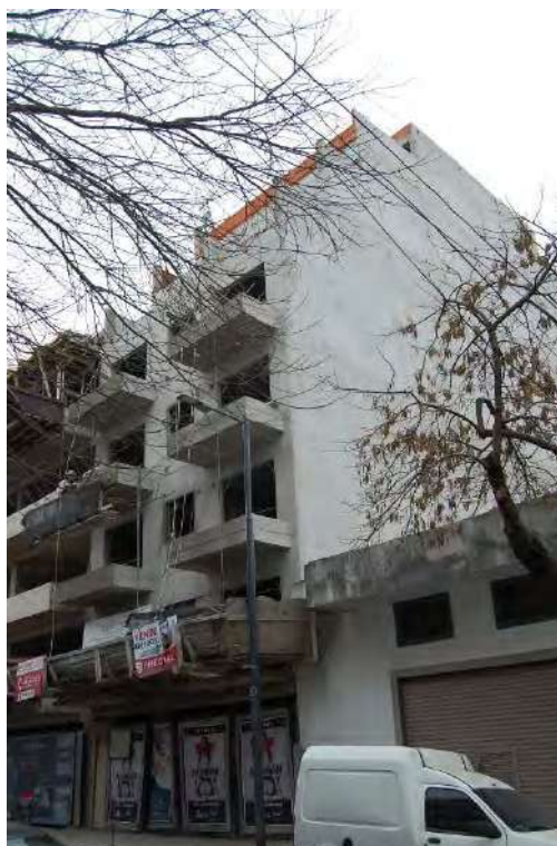
VISTA DE LA OBRA DESDE EL ESTE
