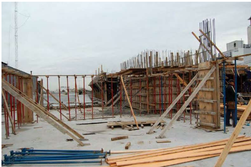
VISTA DE PREPARACIÓN DE LOSA S/4º PISO SECTOR NORTE
