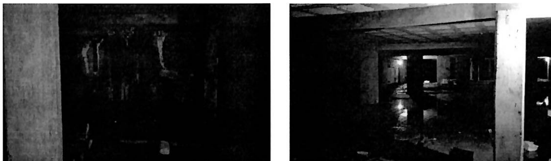
Submuración. Filtración de aguas subterráneas. 3° Subsuelo
