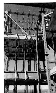
Pisos 12°, 13° y Encofrado Nivel 14°
