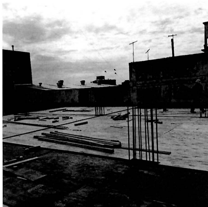
LOSA S/2°P EN DIRECCIÓN SW
