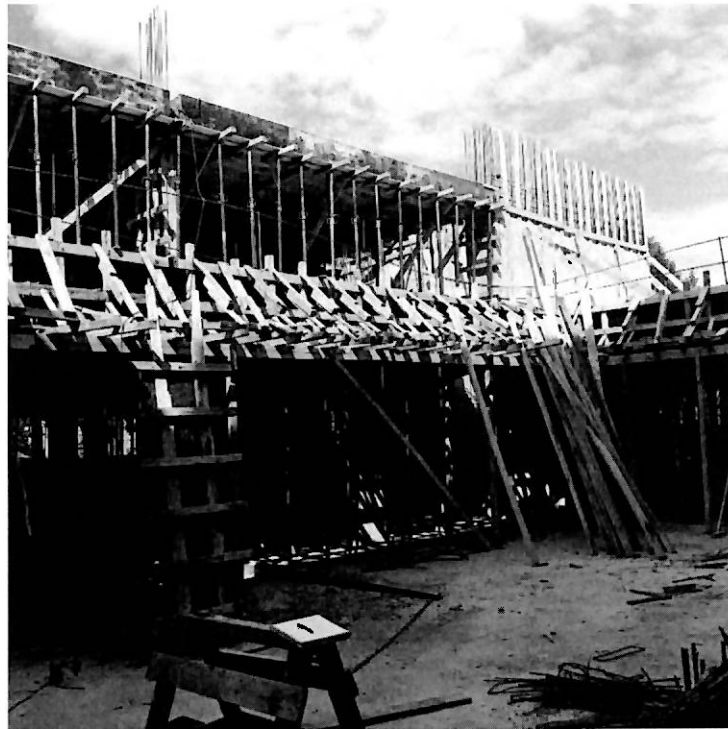
VISTA DE LA LOSA S/1° P EN DIRECCIÓN SW
