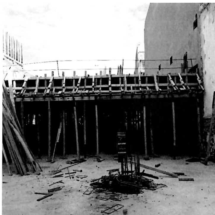
VISTA DE LA LOSA S/1º P EN DIRECCIÓN W
