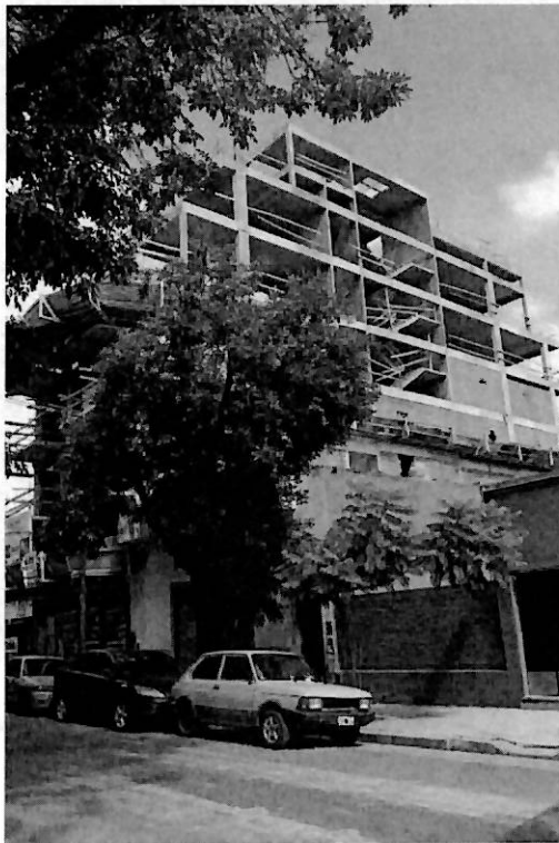
VISTA DE LA OBRA DESDE EL ESTE
