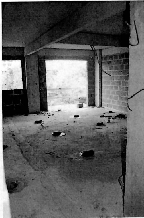
BULINES PARA CONTRAPISO
