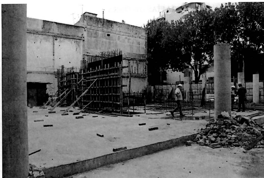
VISTA DE LA LOSA S/1° SS EN ANGULO SE
