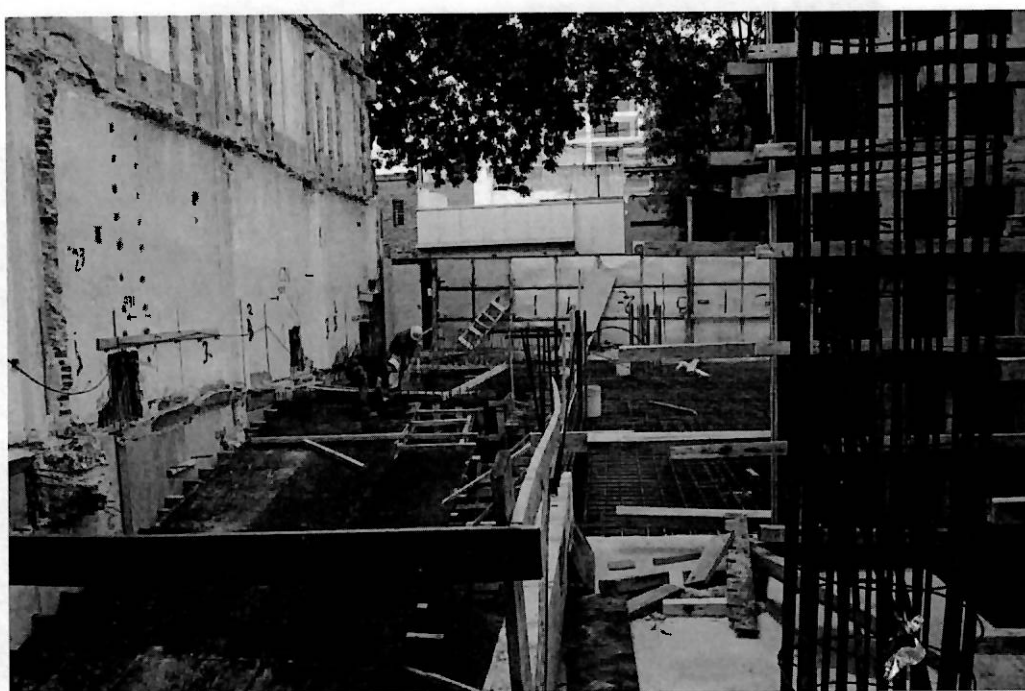
TRABAJOS EN EJECUCIÓN EN LOSA Y RAMPA
