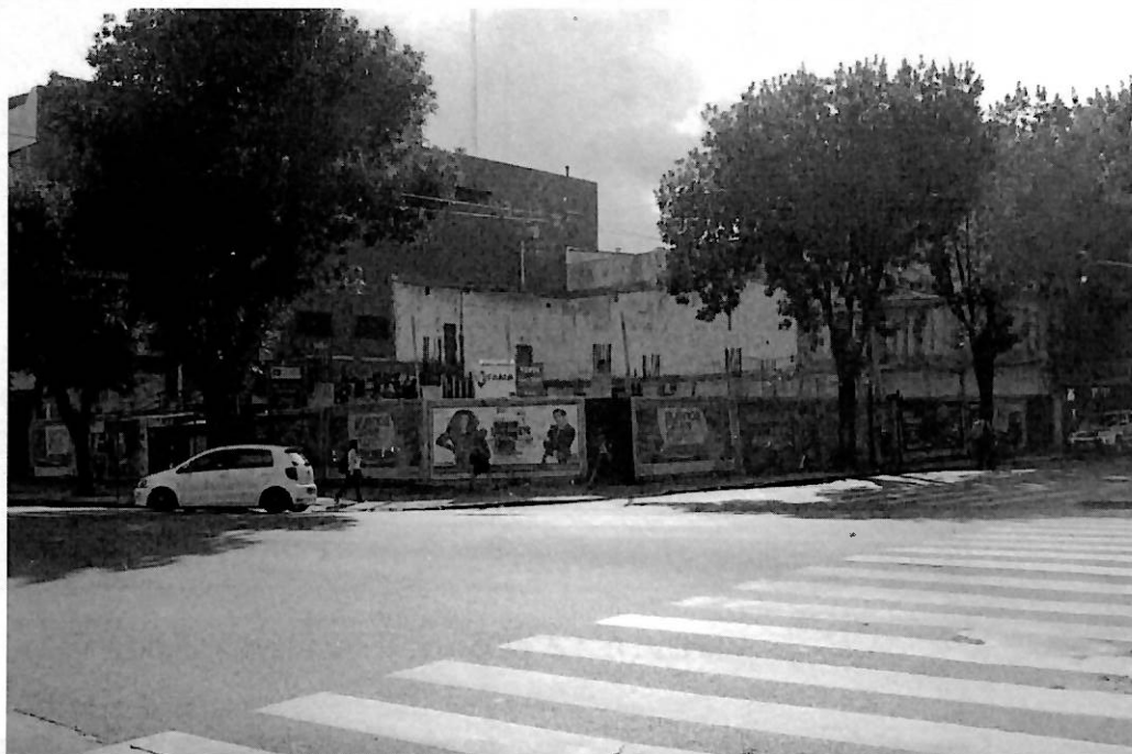
VISTA DE LA OBRA DESDE LA CALLE
